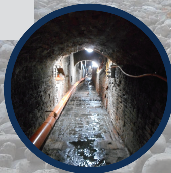
Recupero statico e disinquinamento di parte del Fiaccacollo
