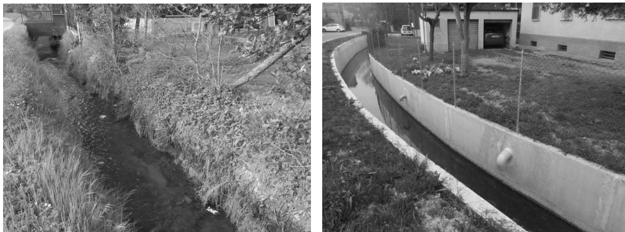
Figura - Esempio di ripristino della funzionalità idraulica nei canale di via Volta
